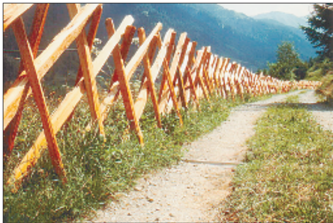
Nicht aus purer Nostalgie, sondern konkret zum Zäunen einer Heuwiese: der für das Goms typische Schratthag.
